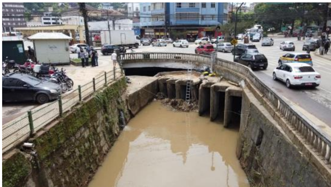
Foto 3.41 - Emboque do Extravador no Rio Palatinato
