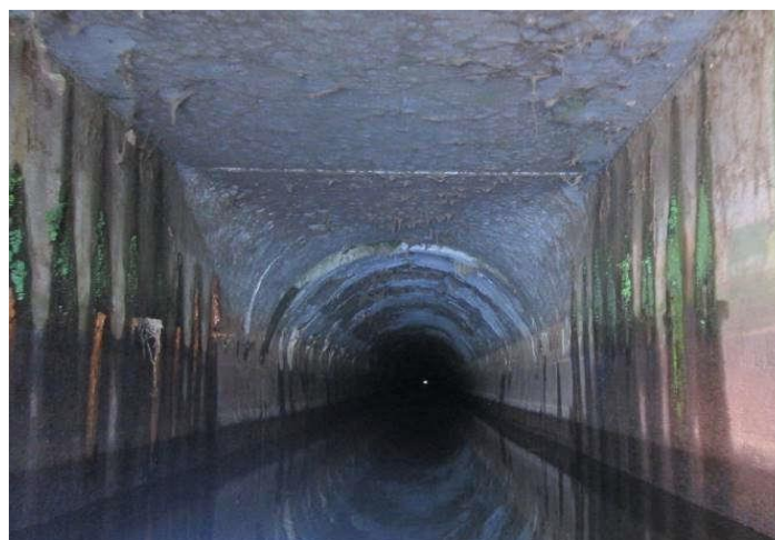
Foto 3.50 - Ponto 2: Trecho de Transição do Túnel Escavado em Rocha para Galeria Celular Seção 4m x 4m
